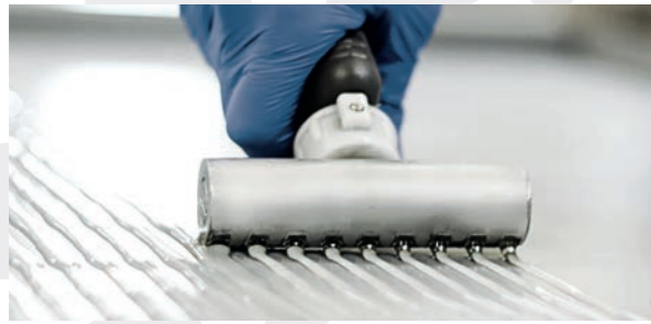
Aplicación de cola
